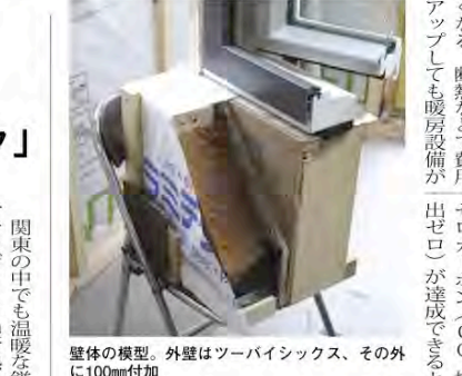
壁体の模型。外壁はツーバイシックス、その外に100mm付加
