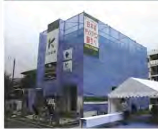
建築中のパッシブハウス
